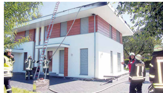
Mit einer Drehleiter und unter Atemschutz bekämpften die Feuerwehr-Männer den Brand auf dem Dach.
