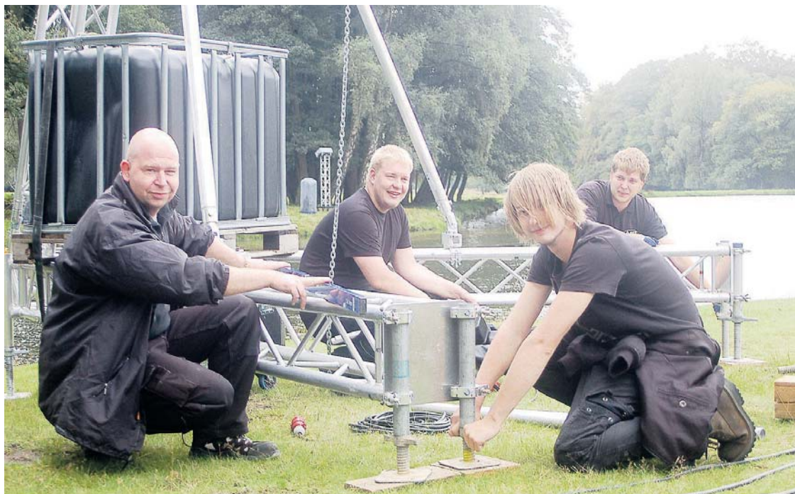
Zusammen mit den Veranstaltungstechnikern sorgt Audio Engineer Karsten Friebe (l.) für die optimale Beschallung im Wildpark. Hier wird an einem Tower gearbeitet, der zu einem ausgewogenes Klangbild beiträgt. DZ-Fotos: Frerichmann
