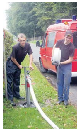
Die Feuerwehr verlegt Trinkwasserschläuche.
