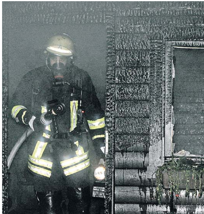
Ein Angriffstrupp wurde unter schwerem Atemschutz in die Hütte geschickt.
