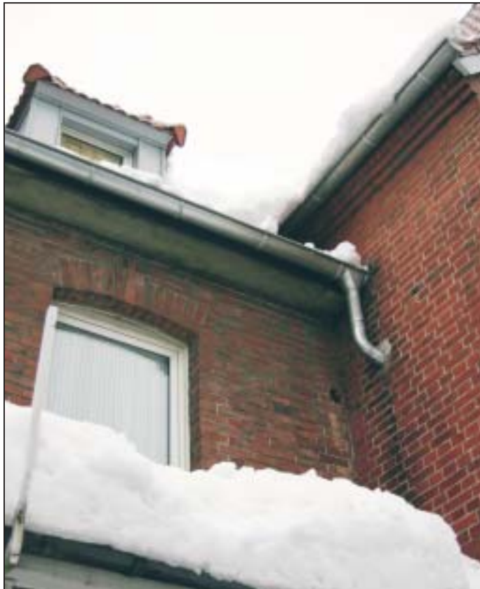
Noch liegt der Schnee wie Watte auf den Häusern. Gewarnt wird allerdings vor Dachlawinen. DZ-Foto: rr
