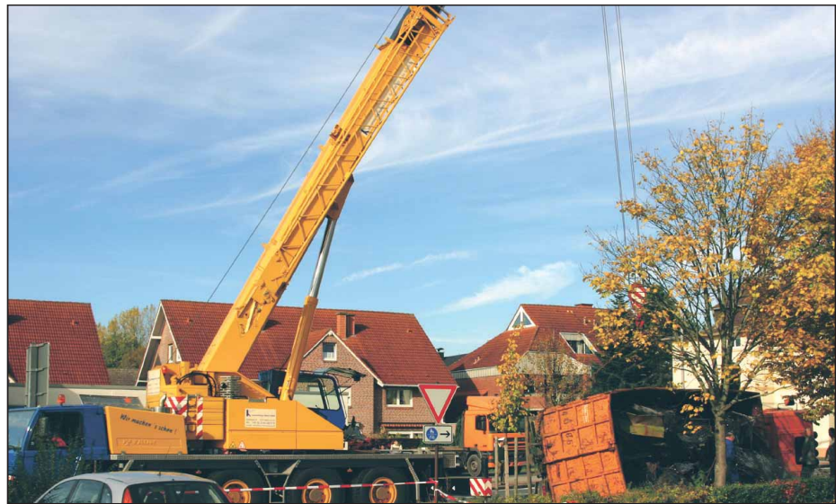
Mit Hilfe eines Autokrans wurde der Lkw auf die Reifen gestellt.
