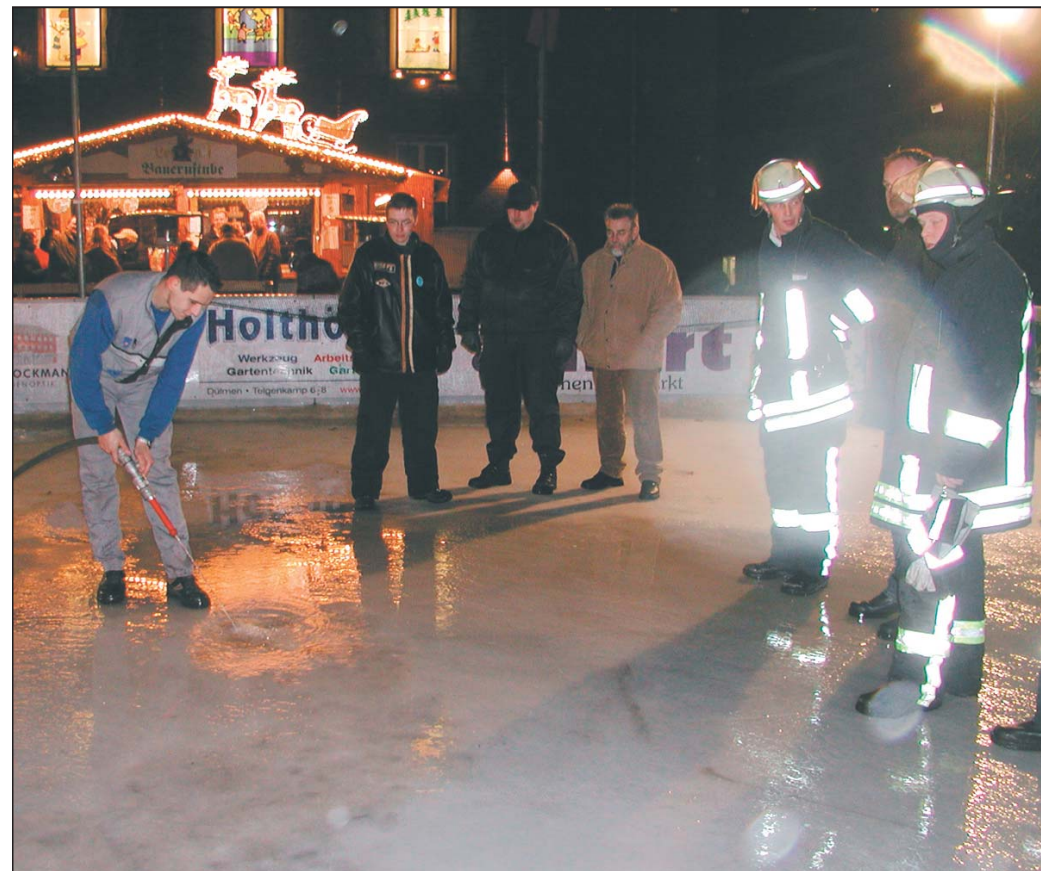
Mit 60 Grad heißem Wasser wurden die Glykolreste weggespült.
